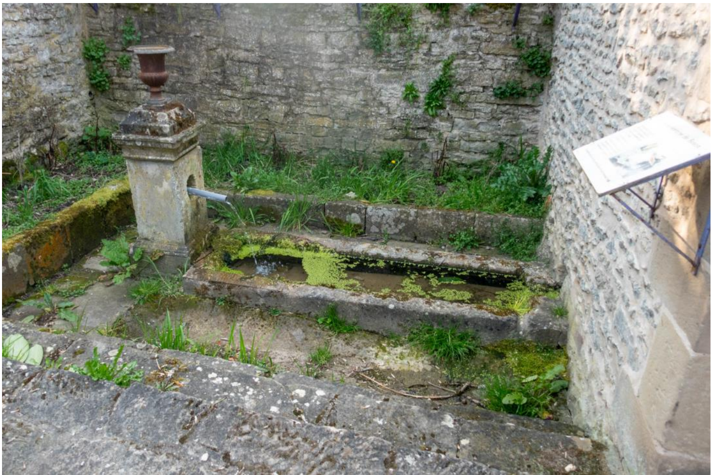
La Fontaine-lavoir du Baxon à Dompaire
