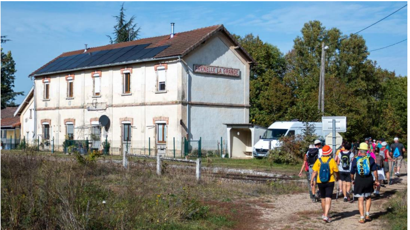
La gare de Frenelle-la-Grande et la traversée de la voie unique.
