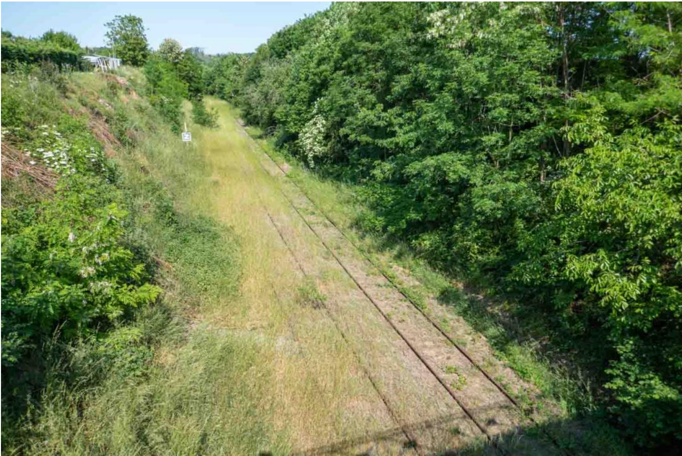
Friche ferroviaire de l'ancienne ligne 14. Photos prises du pont-route de la rue Voivre à Hymont
